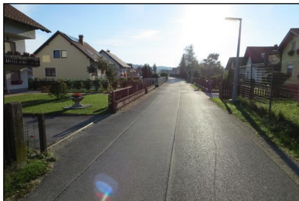
Slika 6: Slabo stanje vozišča z vzdolžnimi razpokami zaradi preteklih razkopov ceste.
