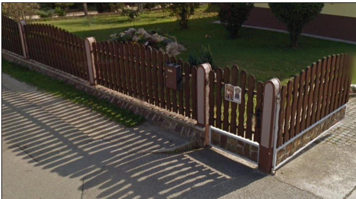
Slika 16: Obstoječa parcelna ograja, ki se poruši. Polnila, stebrički in vrata se začasno odstranijo in montirajo na novi pasovni temelj ob novem robu bankine.
